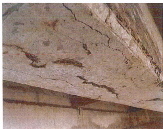
图 9.1.2-8 梁底部开裂
