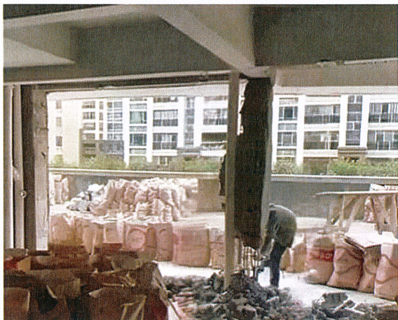
图 4.2.1-1 框架柱拆除
