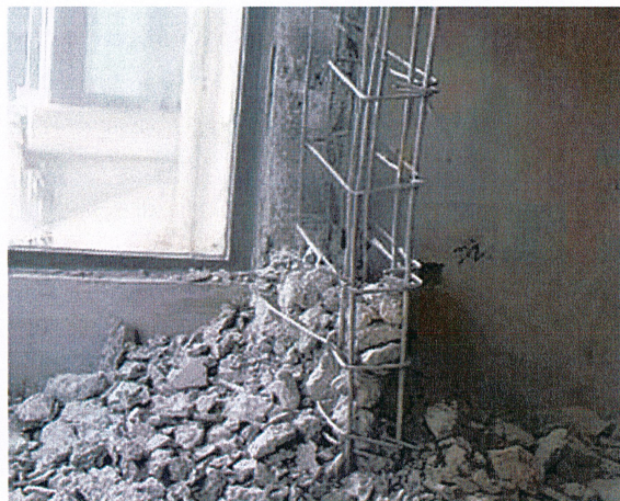
图 4.2.1-2 剪力墙拆除
