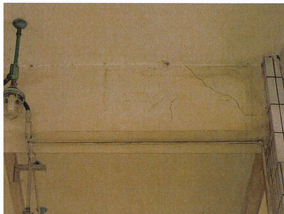
图 9.1.2-10 梁受剪裂缝
