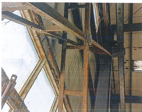
图 9.1.2-13 斜撑锈蚀
