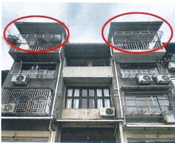
图 4.2.6-1 加建悬挑阳台
