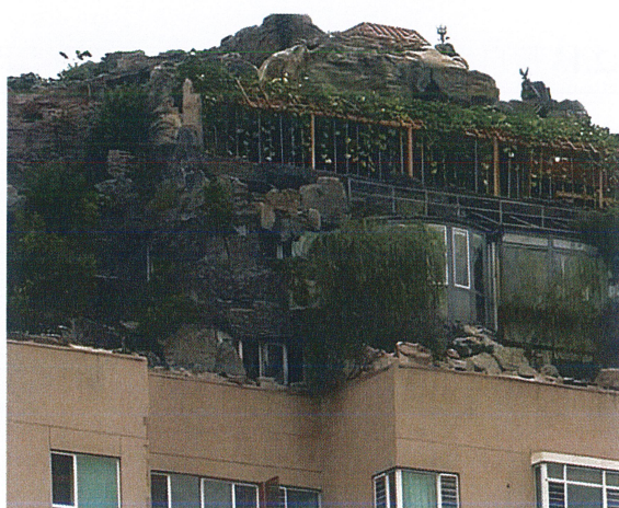
图 4.2.6-2 屋顶加建景观
