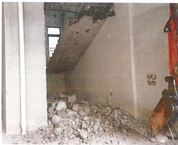
图 4.2.11-1 大型机械拆除楼梯
