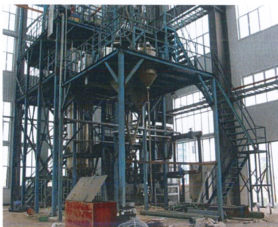
图 5.2.6-1 大型机械独立安装
