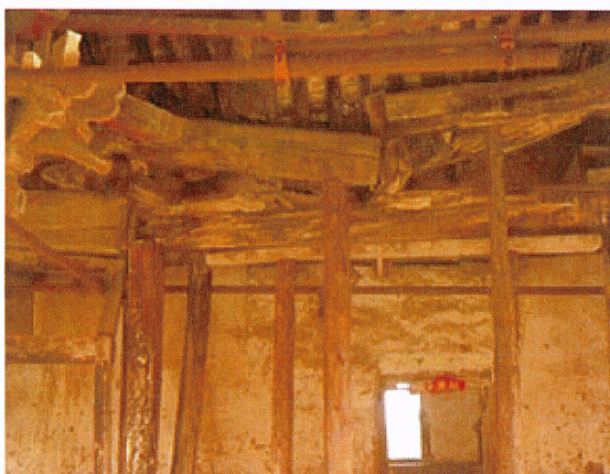
图 9.1.2-11 屋架断裂
