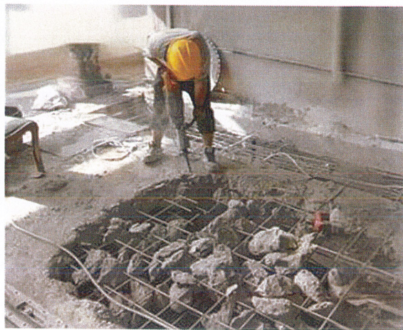
图 4.2.11-2 拆除现浇板
