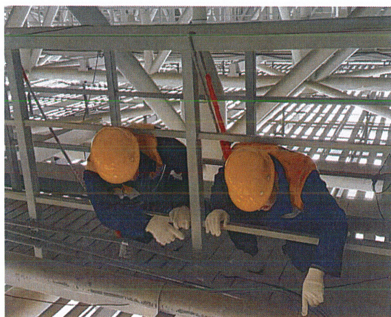
图 5.1.22-1 候车大厅屋盖检查
