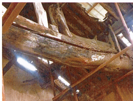
图 9.1.2-12 屋架劈裂
